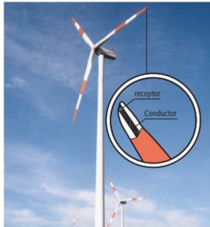
Figura 3.4. Aerogeneradores con receptores integrados en las palas.
