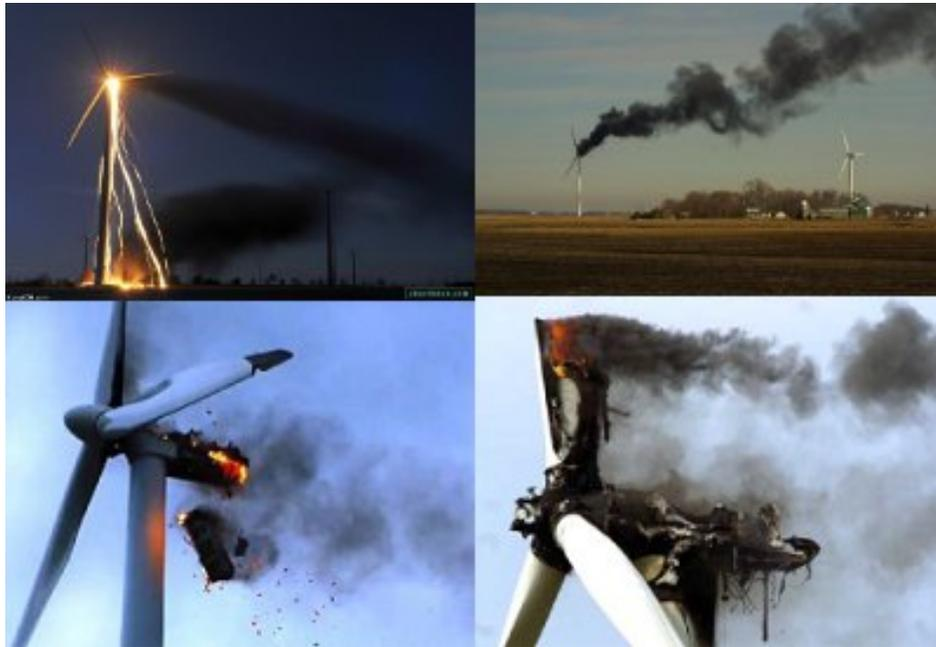
Figura 2.10: Fallas en turbinas eolicas.<sup>6</sup>
